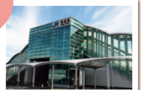
雨の日に荷物を持っていても濡れないように、駅玄関に屋根設置が実現。
